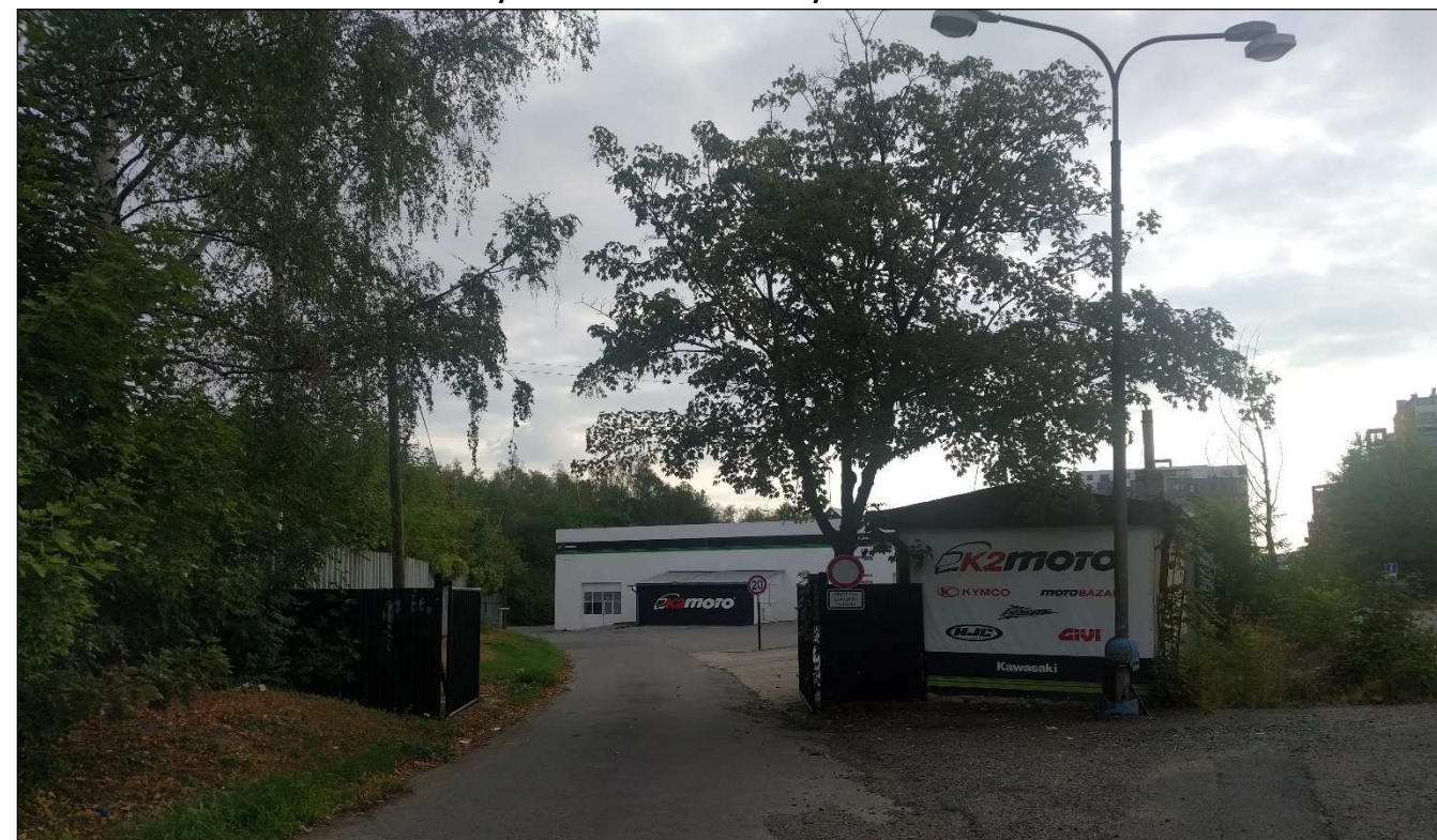
Obrázek 11 Fotodokumentace stávajícího stavu lokality posuzované úpravou č. U 1287/01 ÚP SÚ hl. m. Prahy – pohled z křižení ulic Kabešova a Pod Harfou na východní část řešené lokality
