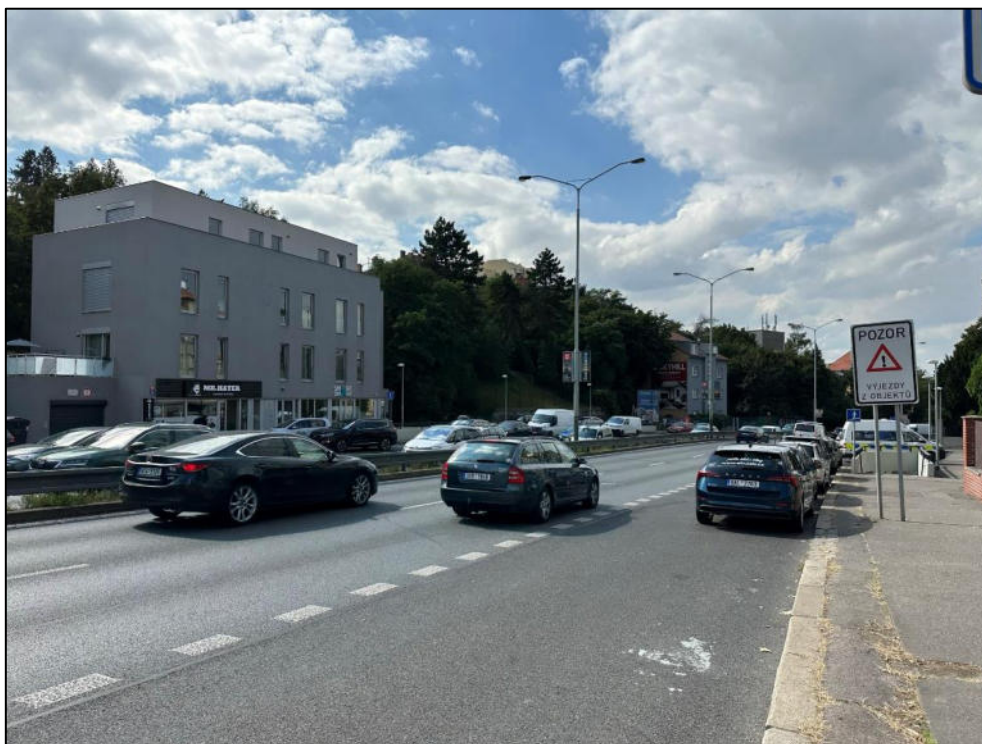
Obrázek 3 – Pohled na komunikaci před měřicím místem M1
