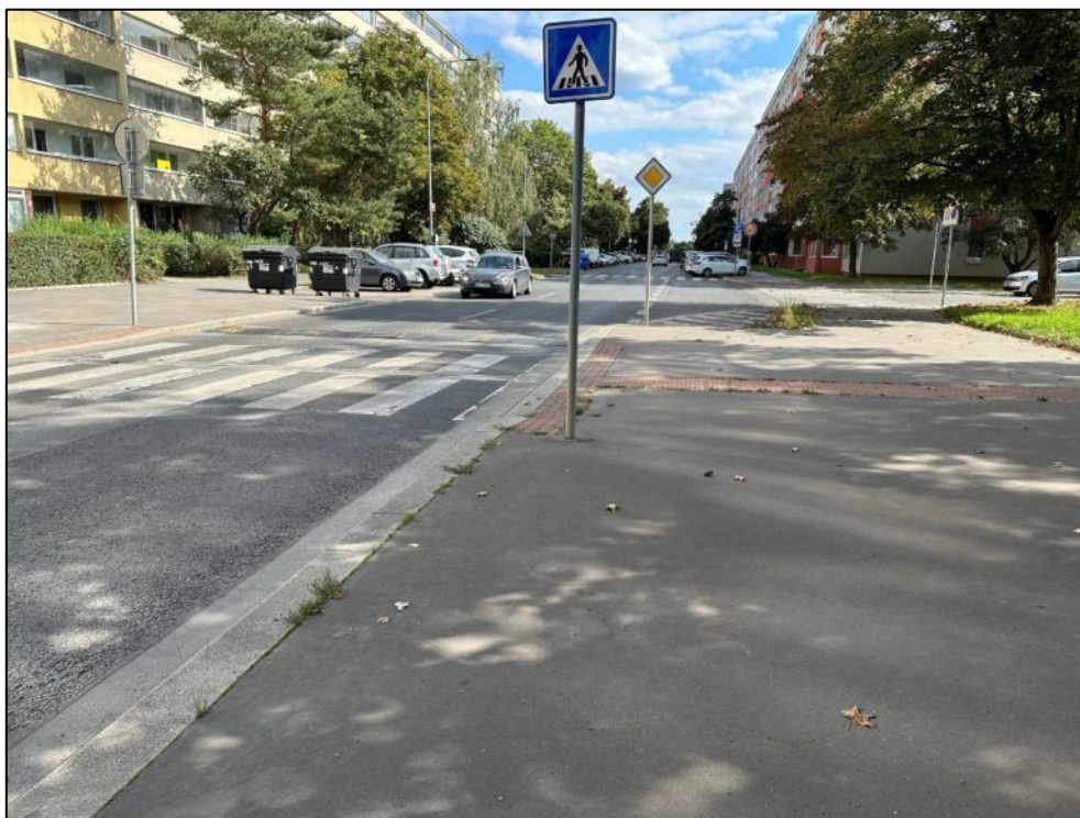
Obrázek 9 – Pohled na komunikaci před měřicím místem M3
