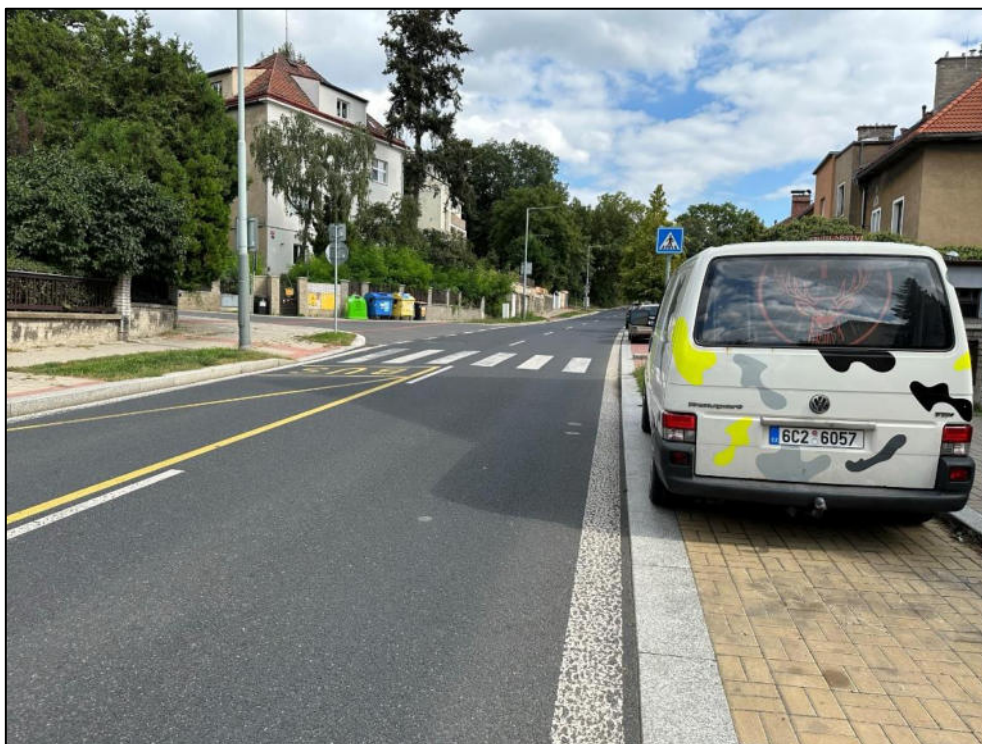
Obrázek 6 – Pohled na komunikaci před měřicím místem M2
