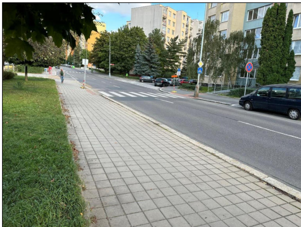
Obrázek 15 – Pohled na komunikaci před měřicím místem M5
